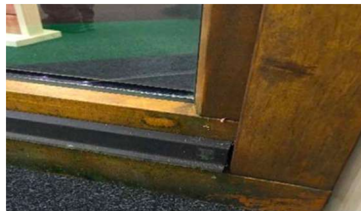
Geen zichtbare coating degradatie
